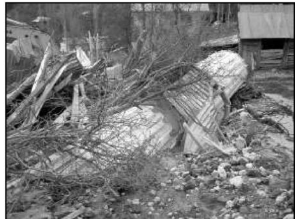
Şekil 2 - Kuzulu (Sivas) heyelanı (a) kayan kütle ile üzerdenmiş Kuzulu mahallesi; (b, c) heyelandan ağır hasar almış evler; (d) heyelandan sonra yıkılan cami (Duman ve diğerleri, 2005).
