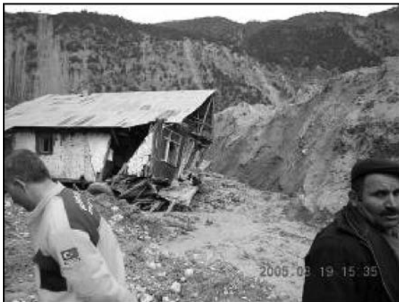
Şekil 2 - Kuzulu (Sivas) heyelanı (a) kayan kütle ile üzerdenmiş Kuzulu mahallesi; (b, c) heyelandan ağır hasar almış evler; (d) heyelandan sonra yıkılan cami (Duman ve diğerleri, 2005).
