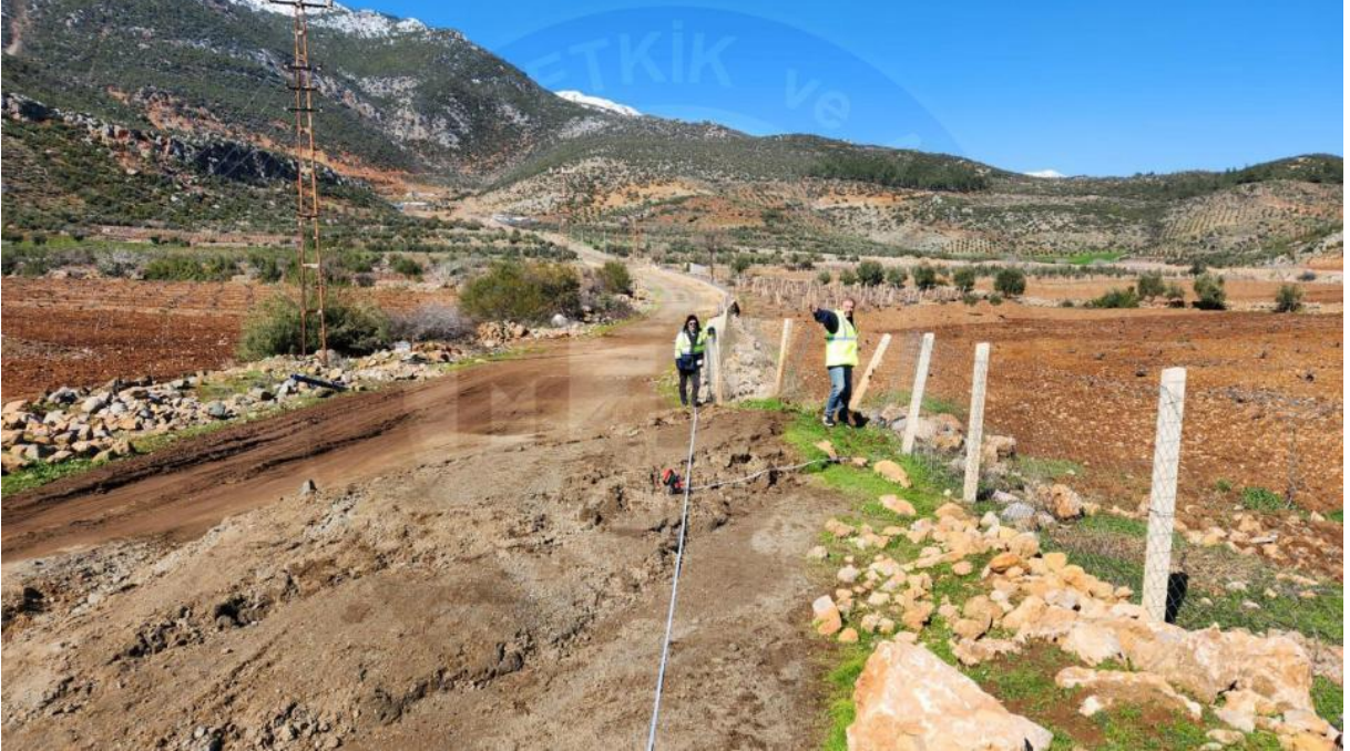
İslahiye güneyinde yol ve bahçe çitinde izlenen sol yanal ötelenme
