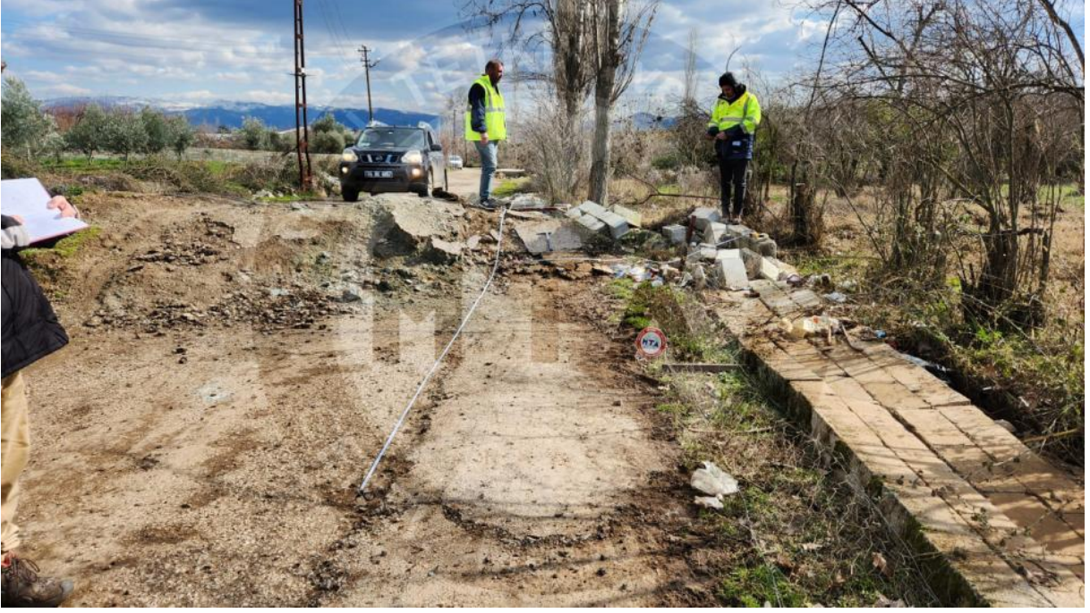
Hassa gneyinde sol yanal telenmiř stabilize yol ve bahe duvarı
