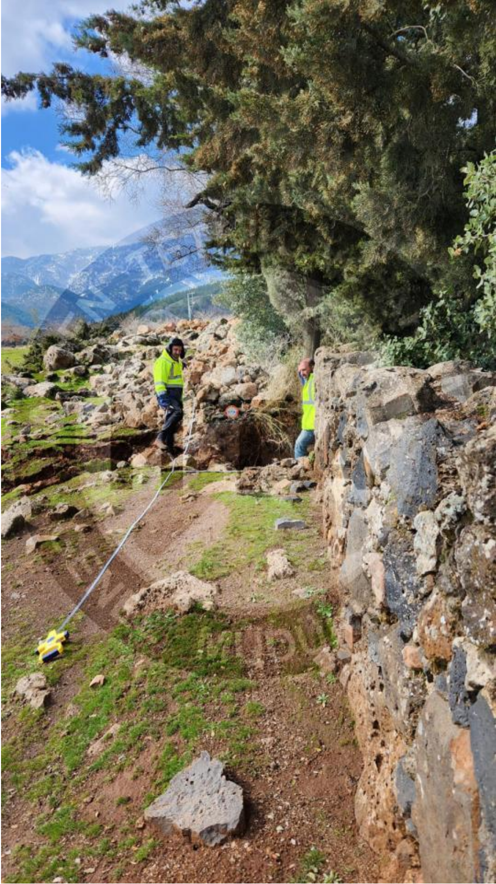
Hassa gneyinde sol yanal telenmiř bahe duvarı ve beraberindeki aēa dizisi
