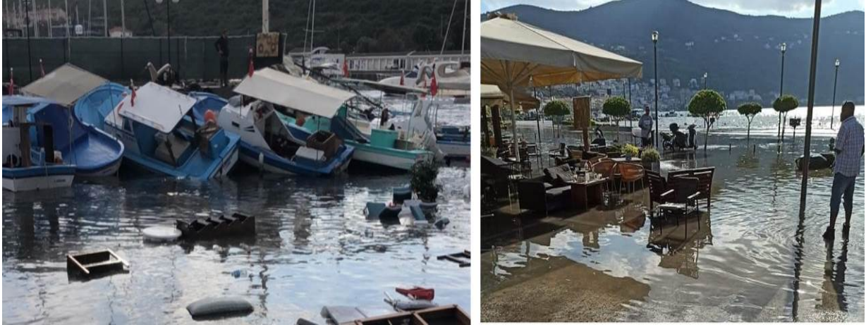
Şekil 5.6. Sığacık Körfezi'nde (soldaki fotoğraf) ve Sisam (Samos) Adası'nda (sağdaki fotoğraf) 30 Ekim 2020 Ege Denizi depreminin tetiklediği tsunami nedeniyle meydana gelen yapısal hasarlar.
