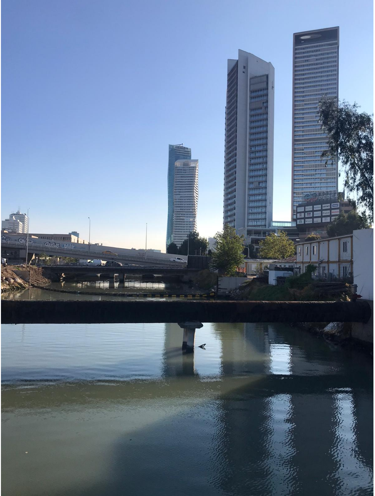
Şekil 5.5. 30 Ekim 2020 Ege Denizi depreminde modern inşaat teknikleri uygulanarak inşaa edildiği için yapısal hasar meydana gelmeyen yüksek katlı binalar (İzmir Körfezi; bakış Doğu'ya).
