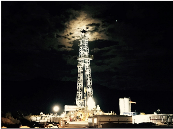
Şekil 3- Jeotermal sondaj kuyusu açan sondaj makinasından bir görüntü (Jeotermal Elektrik Santral Yatırımcıları Derneği, JESDER, 2021).
