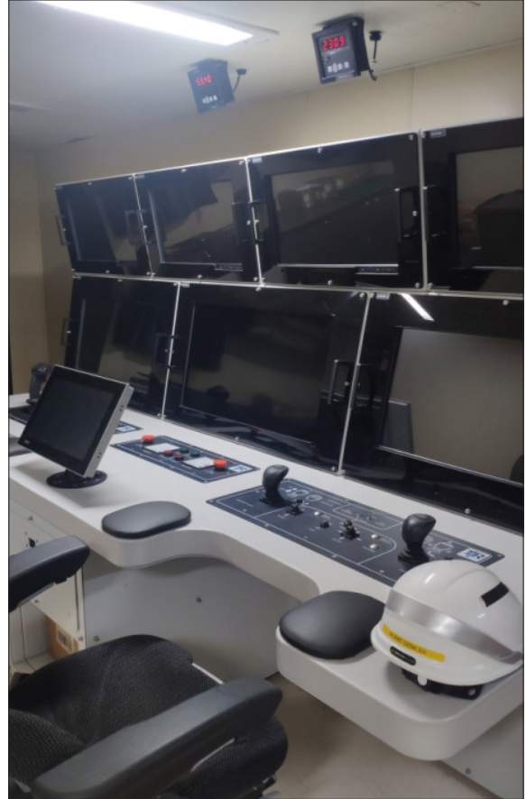
Şekil 4- ROV kontrol odası.
