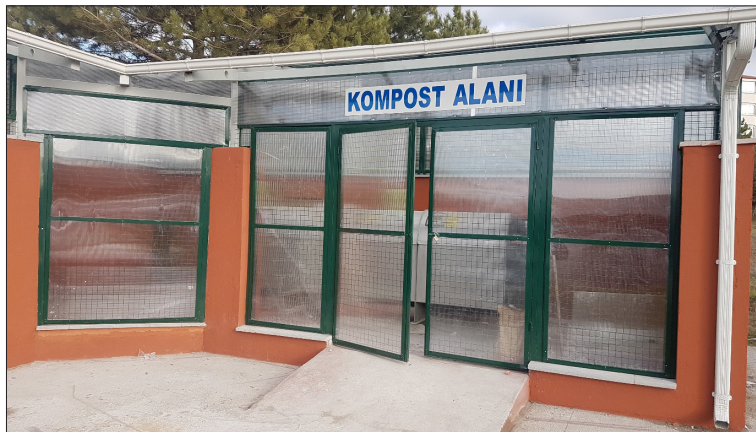
Şekil 8- Yemekhane sebze atıkları ve çay ocaklarından toplanan çay posalarının komposta dönüştürüldüğü kompost makinasının kurulduğu alan.
