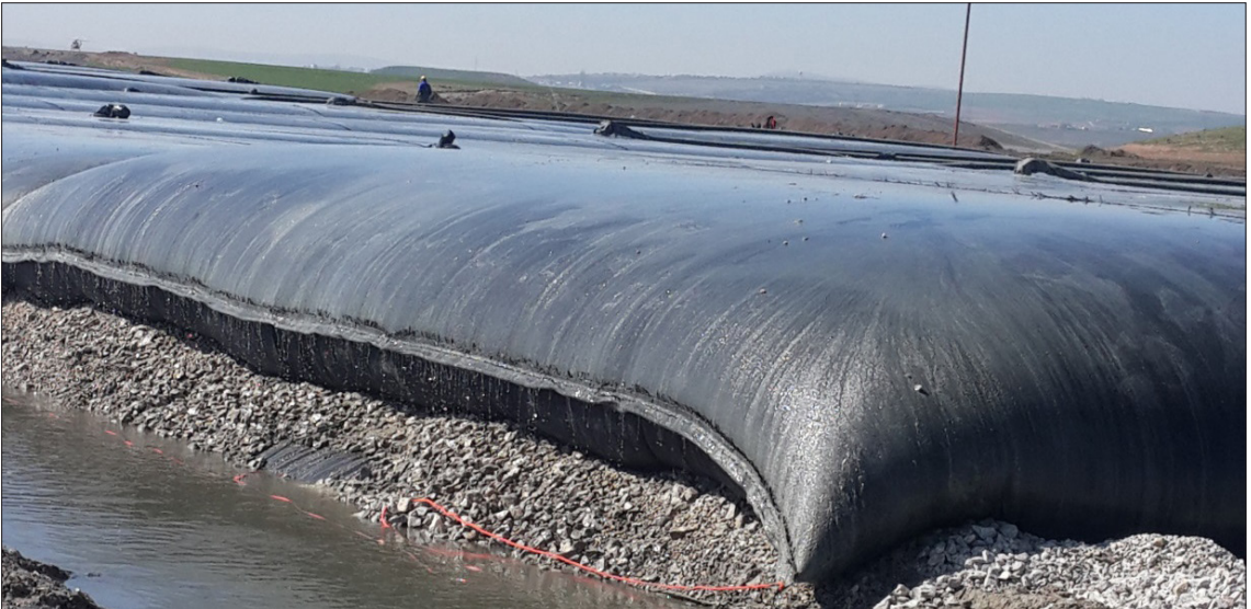
Foto 1- Mogan gölü dip çamuru temizleme projesi kapsamında gerçekleştirilen jeotekstil tüp ile susuzlandırma çalışması ( Nisan, 2018).
