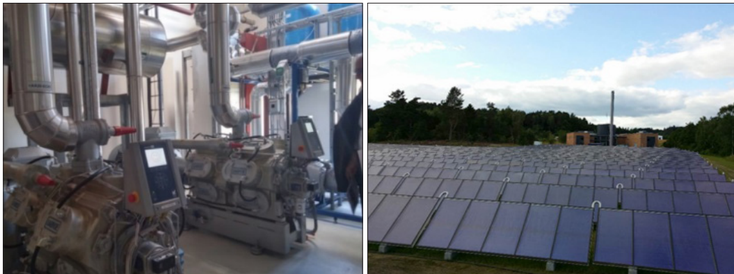
Şekil 11- a) Su kaynaklı ısı pompası b) Güneş toplayıcıları ve ısı merkezi genel görünüm.
