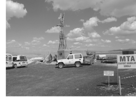
Niğde-Bor-Badak Köyü sondaj sahasından bir görünüm.
