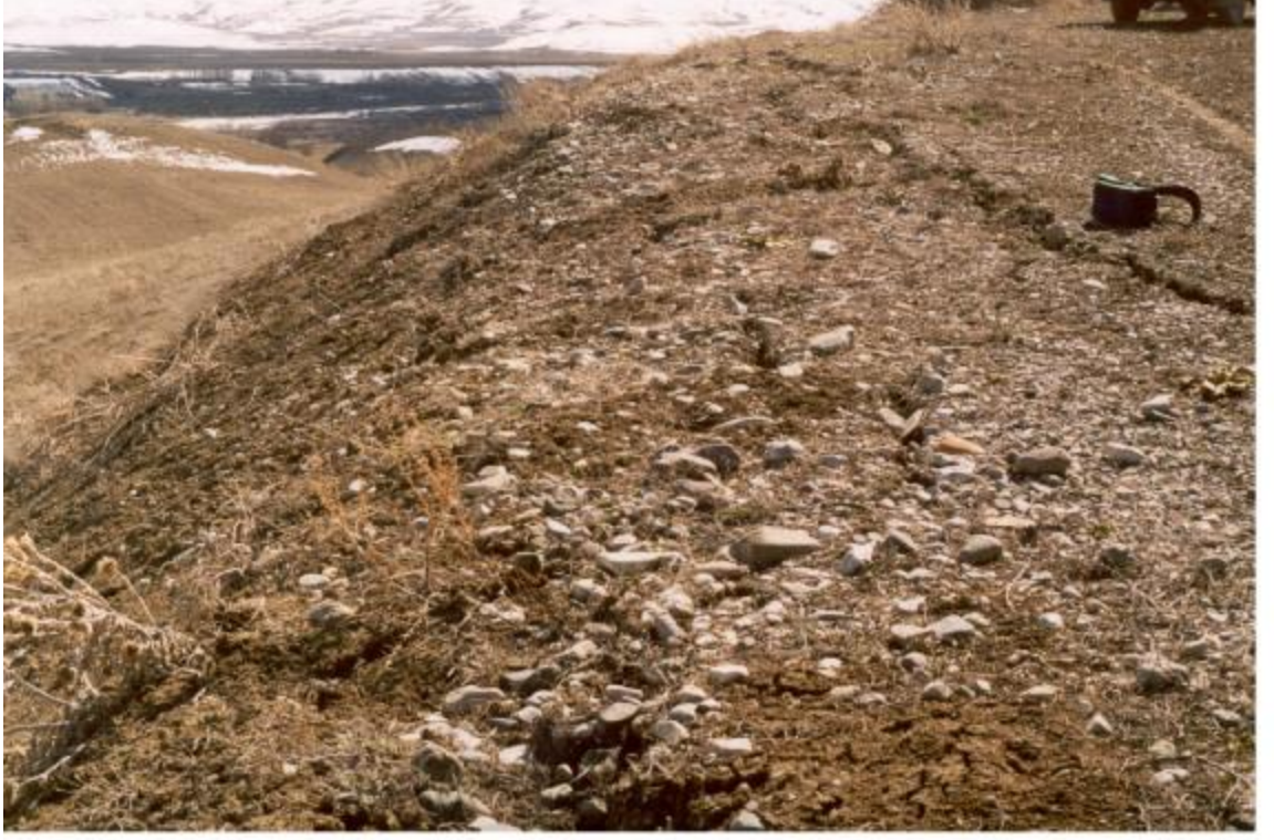
Foto 10: Gökçebük Köyü batısında tali yolda görülen eski bir heyelan kütleinin reaktivite kazanması. Bakış güneydir.
