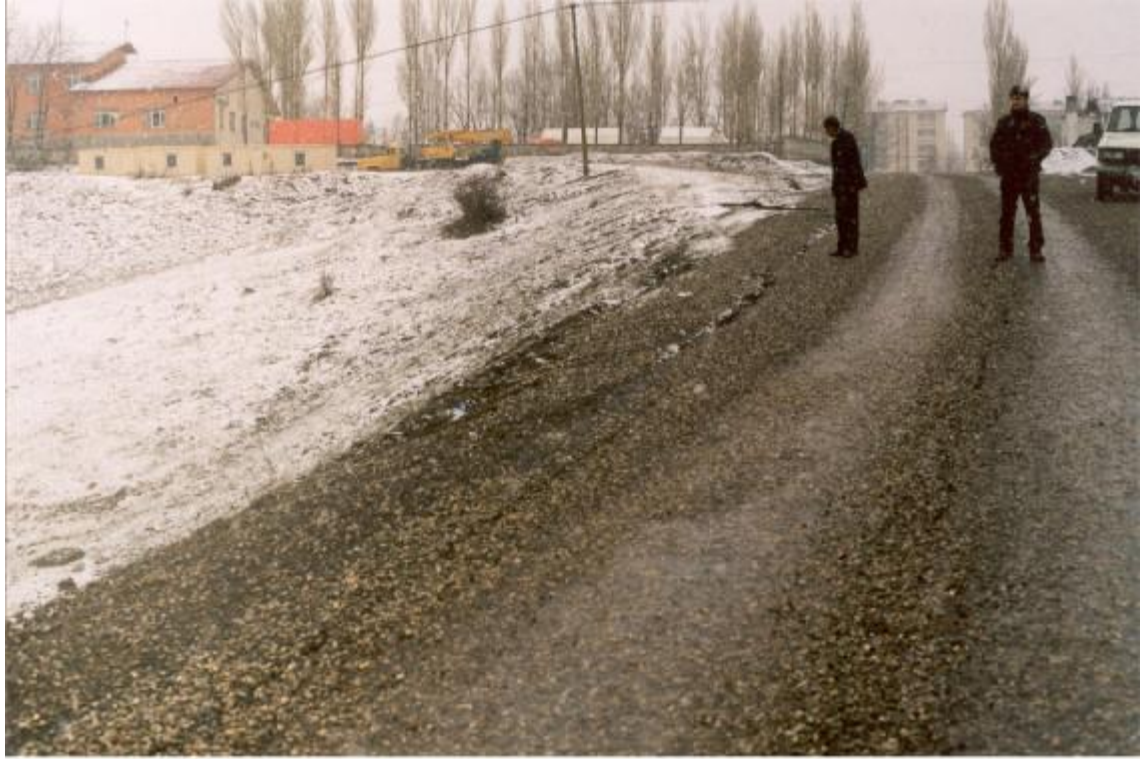
Foto 6: Kandilli-Karabıyık Köyü yolu üzerinde meydana gelmiş dairesel kaymalar. Bakış güncedir.
