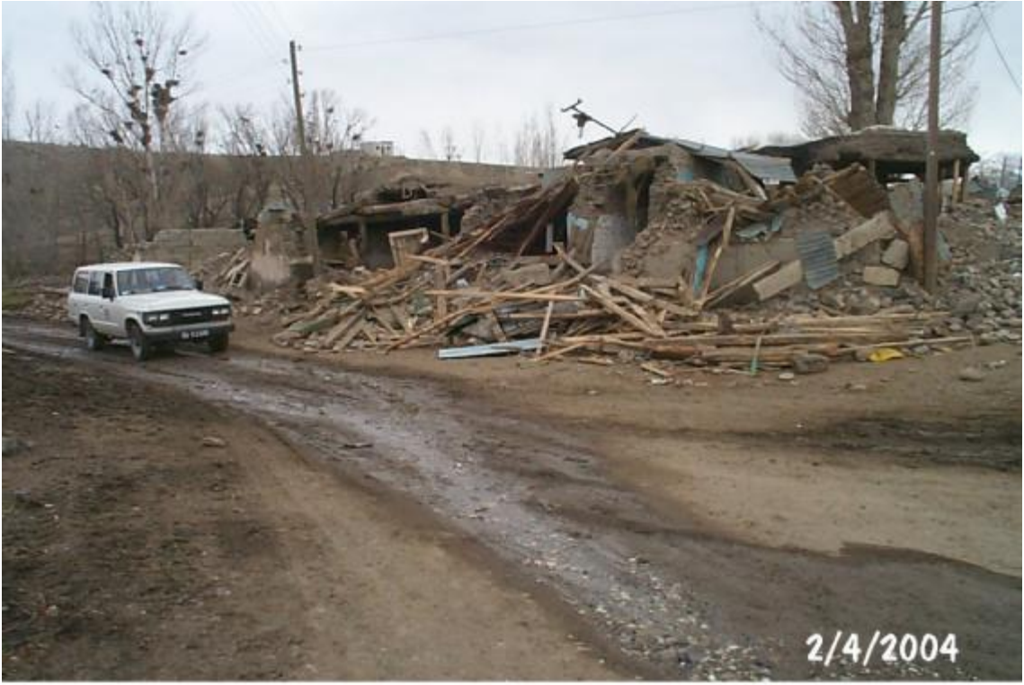
Foto 23: Tazegül Köyünde geleneksel yığma yapılarda depremde meydana gelen hasar.
