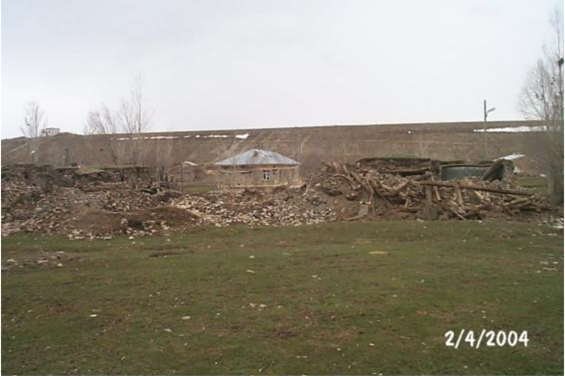
Foto 24: Tazegül Köyünde geleneksel yığma yapılarda depremde meydana gelen hasar.
