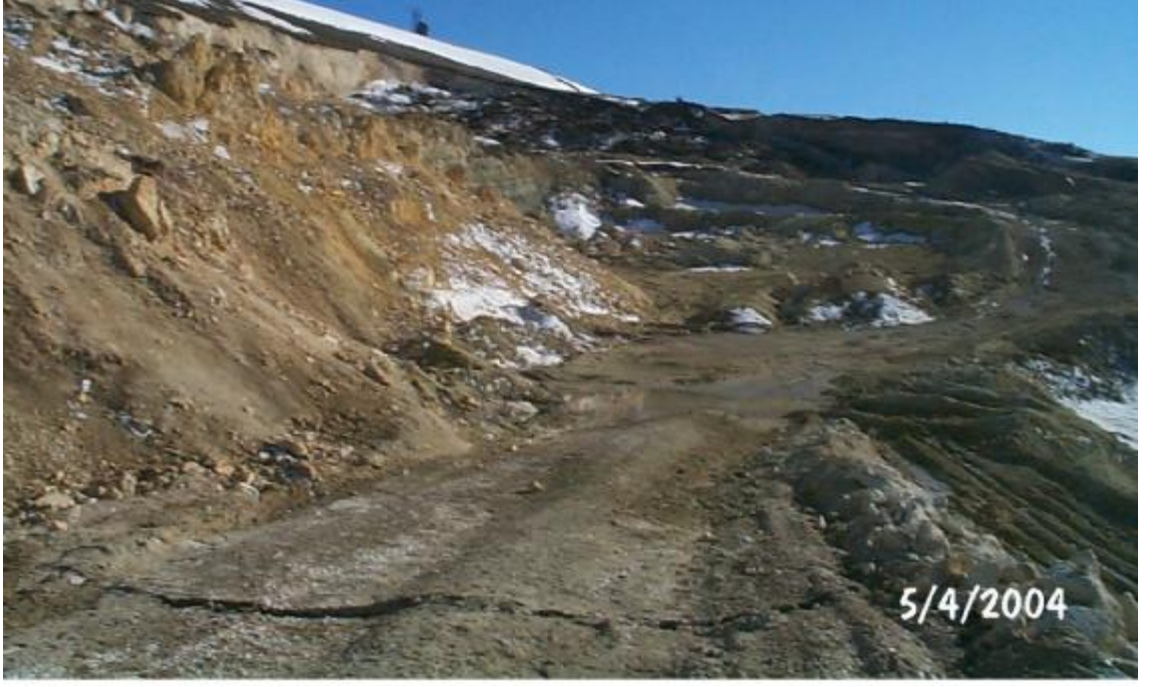
Foto 11: Aşkale ilçe merkezi güneydoğusunda taşocağında görülen dairesel kaymalar. Bakış güneydoğuyadır.
