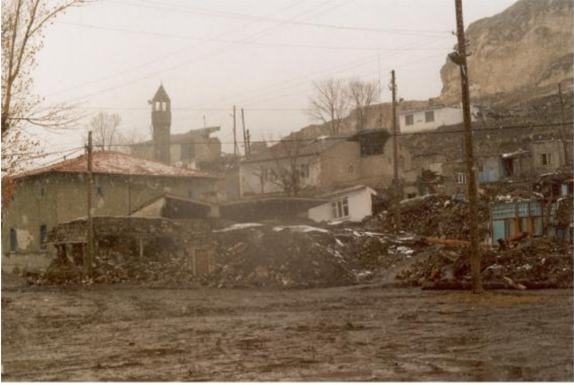
Foto 27: Küçükgeçit Köyünde geleneksel yığma yapılarda depremde meydana gelen hasar.
