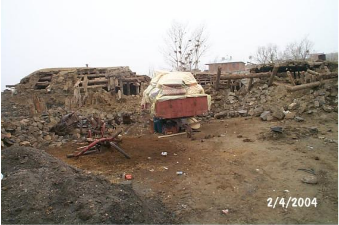
Foto 20: Alaca Köyünde geleneksel yığma yapılarda depremde meydana gelen hasar.
