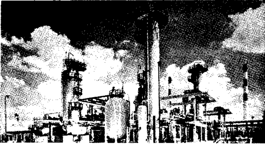
Fransa'nın Lacq havzasındaki tabii gaz epürasyon ünitelerinden bir görünüş.
